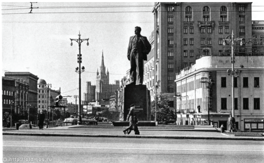
Площадь Маяковского. Справа трёхэтажное здание театра «Современник»
