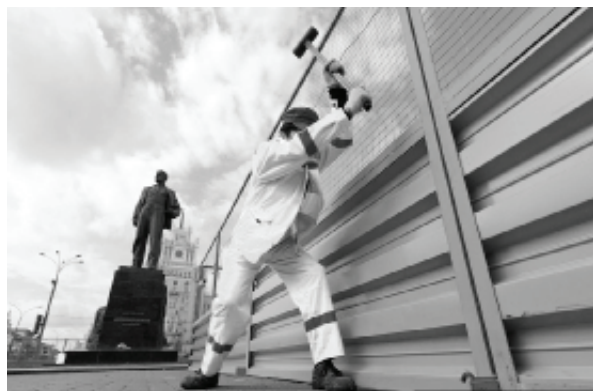
Закрыто на ремонт
